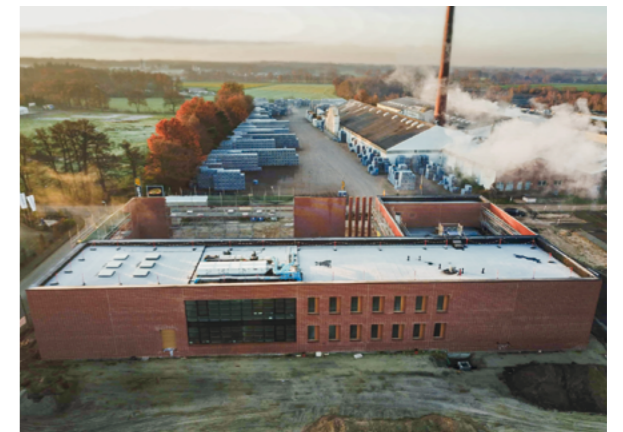
Bürogebäude OLFY Ziegelwerke in Vechta
